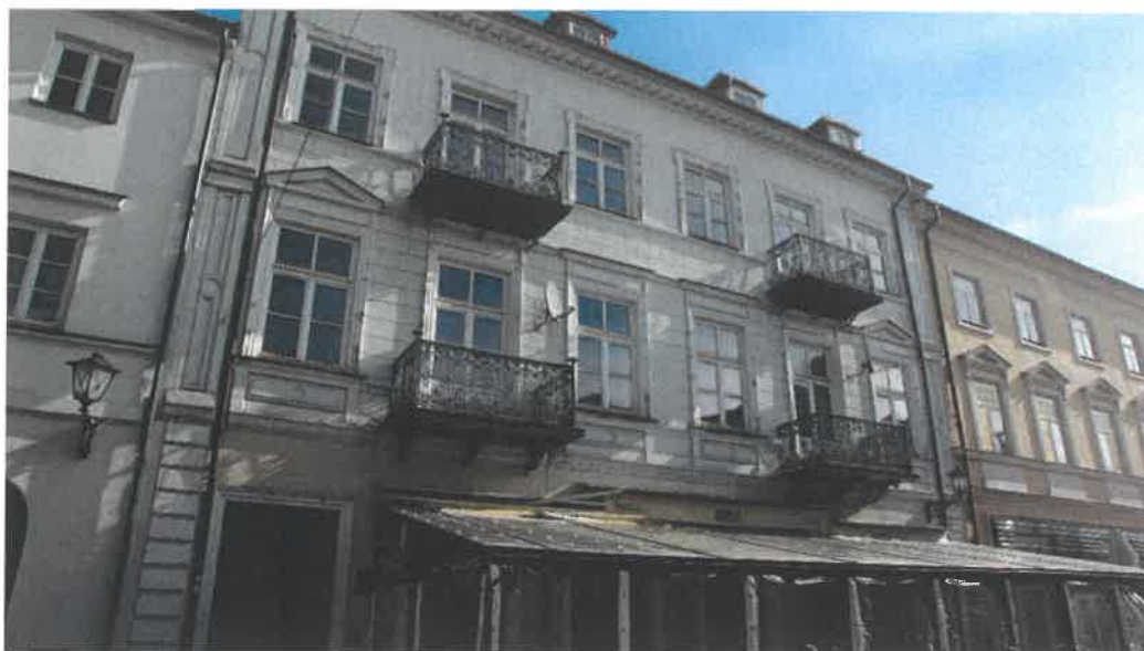
Fotografia nr 1. Elewacja frontowa od strony ul. Grodzkiej.
