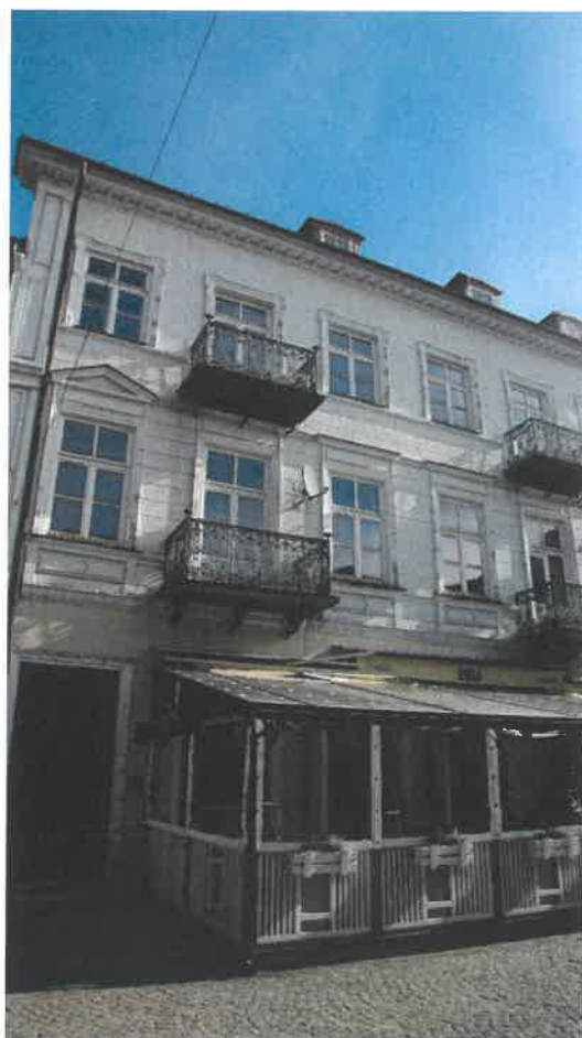
Fotografia nr 2. Elewacja frontowa od strony ul. Grodzkiej.
